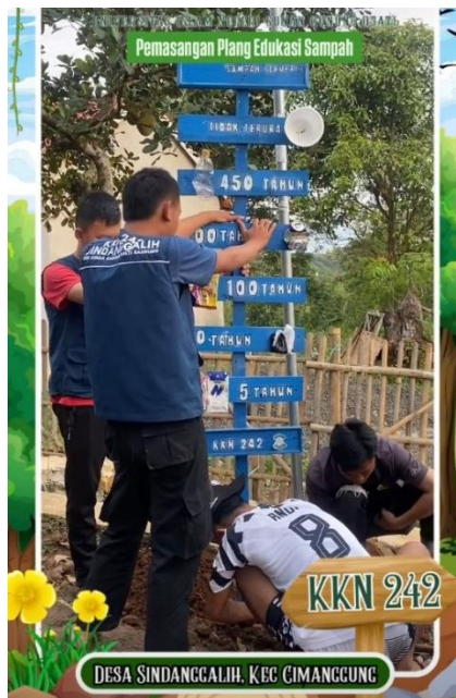
Gambar 2. Pemasangan Plang Sampah
