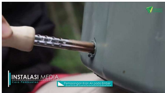
Gambar 10. Melubangi ember yang akan digunakan sebagai media
